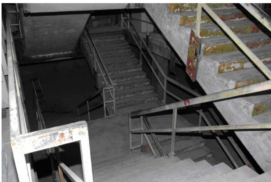
Blick auf den Treppeneinstieg vom EG von der Nordseite
